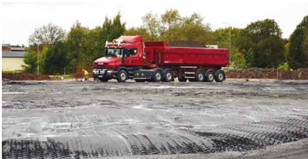
Nytt bränslelager byggs med markbetong av askor.
