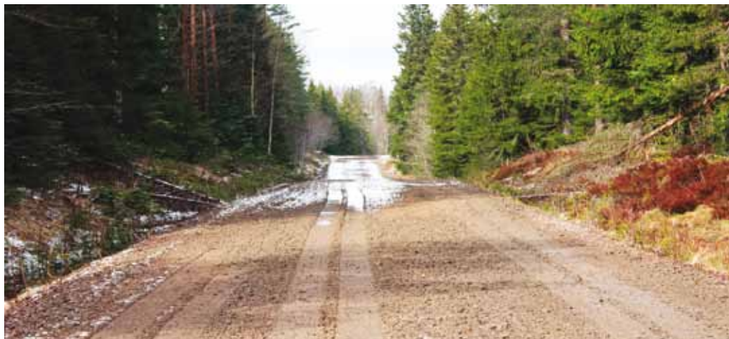
Aska har gjort grusvägen i Norberg tåligare vid tjällossning och regn jämfört med andra skogsvägar utan aska och höjt vägens livslängd avseendevärt.
