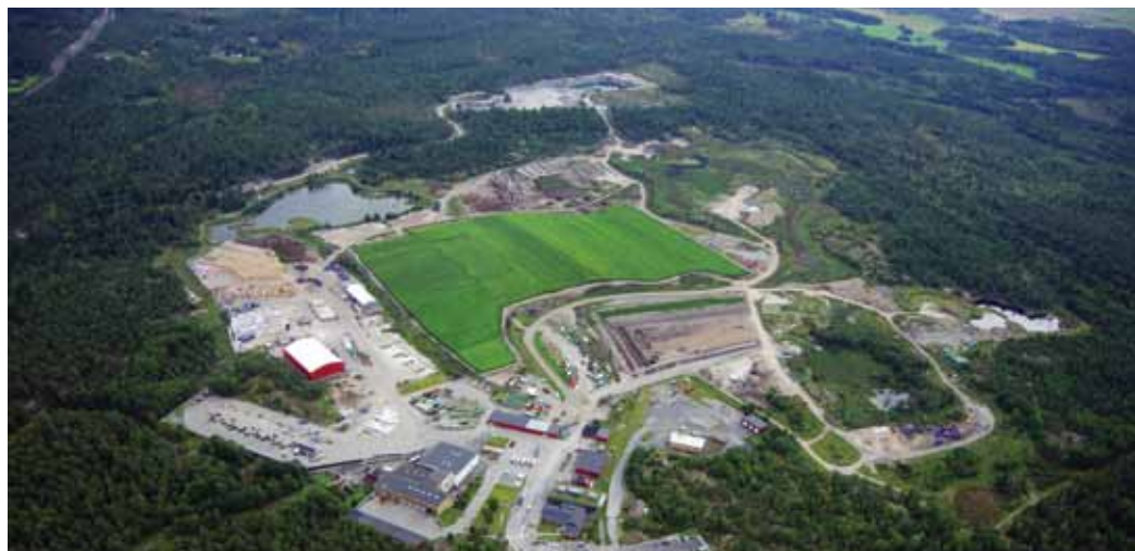
På Lilla Nyby, några kilometer utanför Eskilstuna, använder man sig av en blandning av aska och slam som tätningsmaterial.
